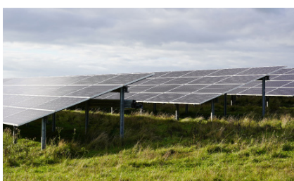
Solcellepaneler på faste stativer.
